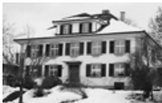
Pestalozzihaus; Zentrum mit Heim, Schule, Therapien, Hof
